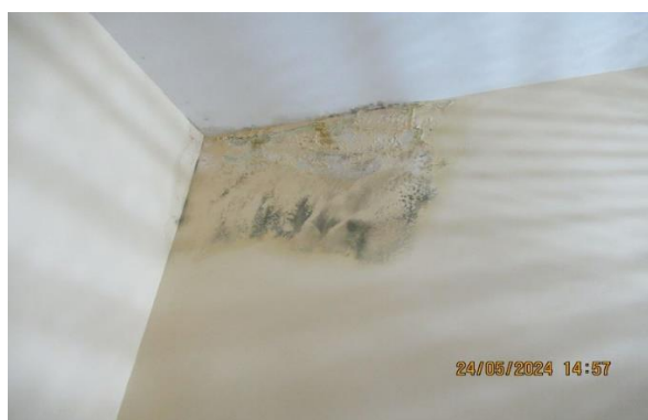
влага на зиду једне од просторија за задржавање ПС Вршац
